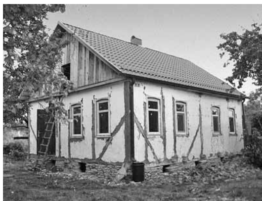
und Anfang September mit neuem Dach, Fenstern und Türen
