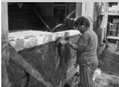
Die Fächer werden mit Stroh gefüllt und mit Lehm verputzt
