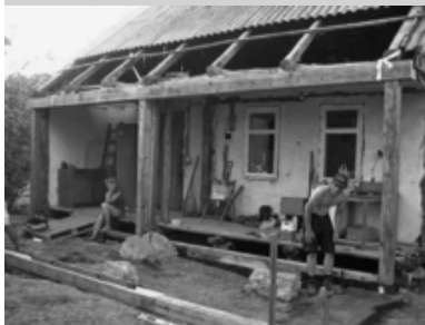
Das Fundament für einen Vorbau wird gelegt
