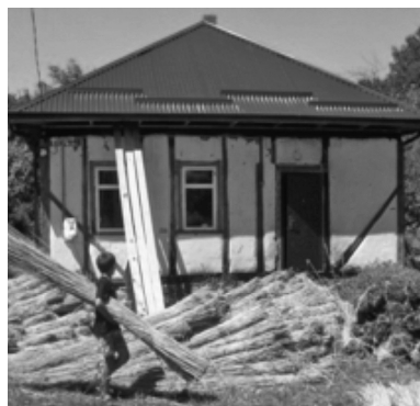
Neues Dach und kaum noch Brandspuren
